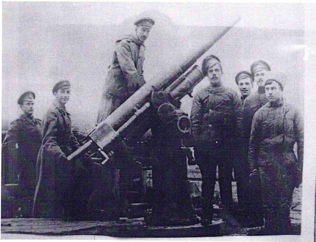
Приложение 4. Испытание на ГАПе (Ржевский полигон) трехдюймовой зенитной пушки образца 1915 г. конструкции Ф. Ф. Лендера.
